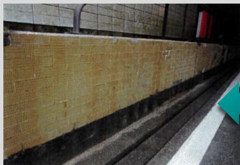
③ ケレン棒(ヘラ)をタイルの背面に差込むとタイルが簡単に剥がれ落ちます。
